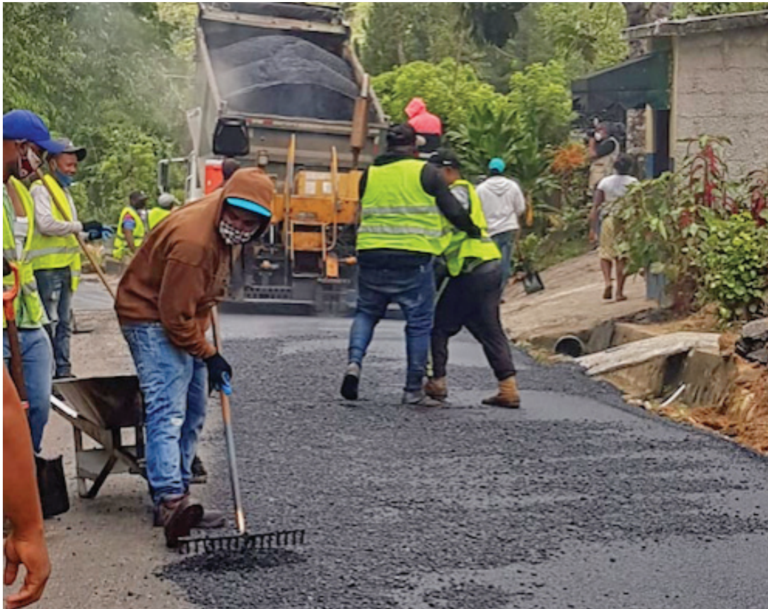
Así quedo el tramo carretero Jamey-Hato Damas, llevando la felicidad de los moradores de cuatro comunidades.
