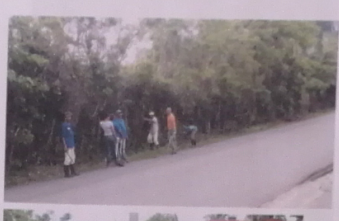
El miércoles 8 de mayo, las brigadas de nuestra Junta Municipal hicieron un operativo de limpieza de canchales y alcantarillas desde la comunidad de La Cabuya hasta el Puente de Boruga.
